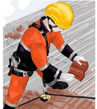
Мал. 5. Захисна каска для висотних робіт
